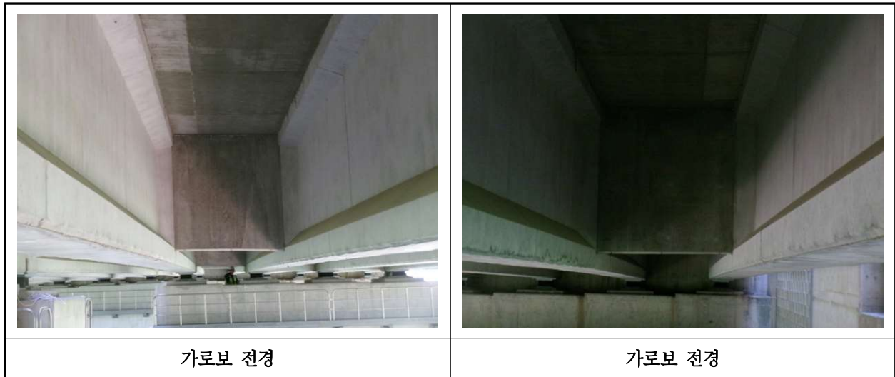
【사진 45.3.10】 가로보 전경
