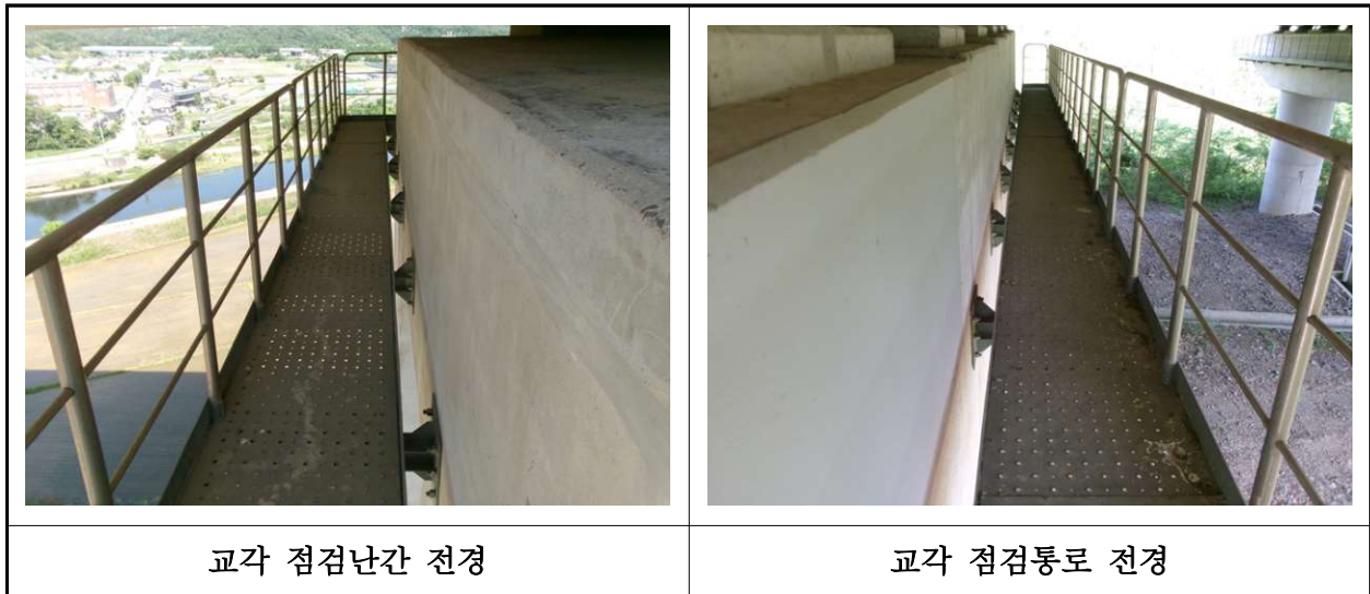
【사진 45.3.30】 교량 점검시설 전경
