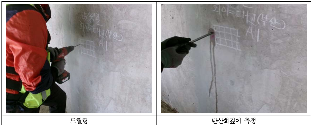
【사진 45.4.3】 탄산화 깊이 측정 현장사진
