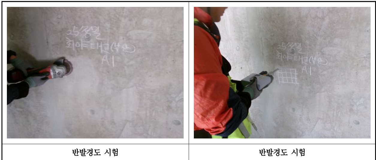
【사진 45.4.2】 반발경도시험 현장사진
