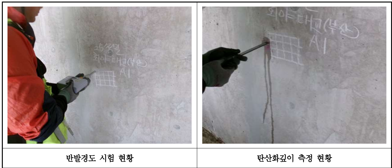
【사진 45.4.1】 콘크리트 내구성조사 현황
