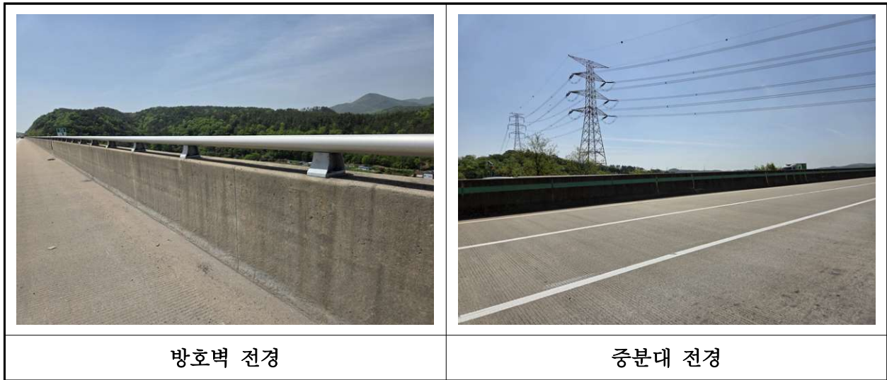
【사진 45.3.28】 방호벽 및 중분대 전경
